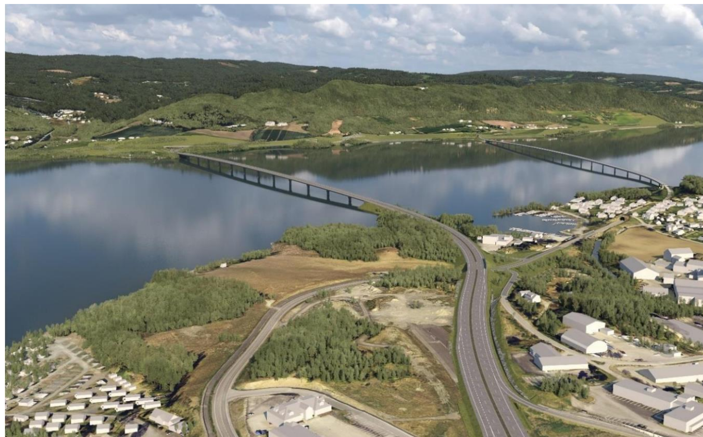
Bildet viser ny bru – alternativ sør – og eksisterende bru
